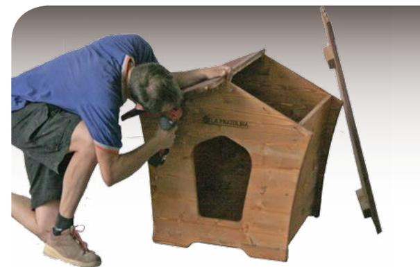
Posizionate le due falde del tetto e fissatele con le viti 5x50, da inserire nei fori del frontale e del retro della cuccia.
